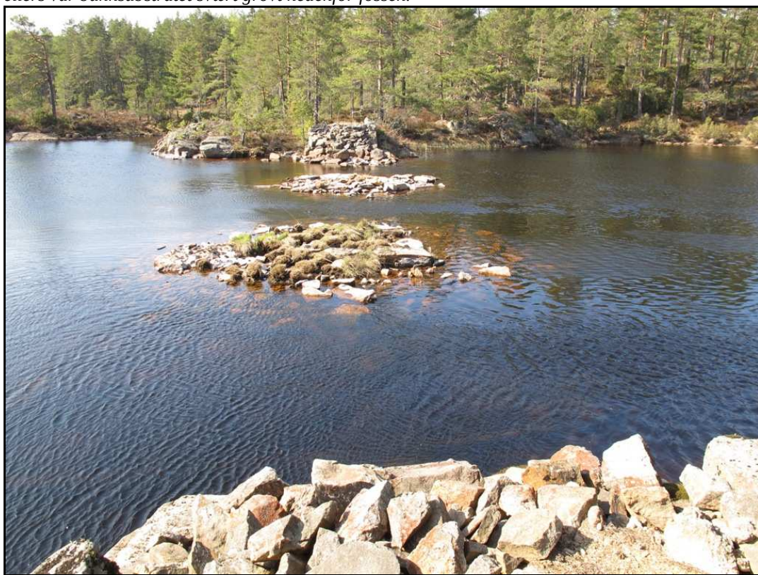
Bilde 7. Restene etter bro for Arendal-Evje vegen. Broa ble tatt av flommen på 1930-tallet (pers.medd. Arnt Olav Furholt).
